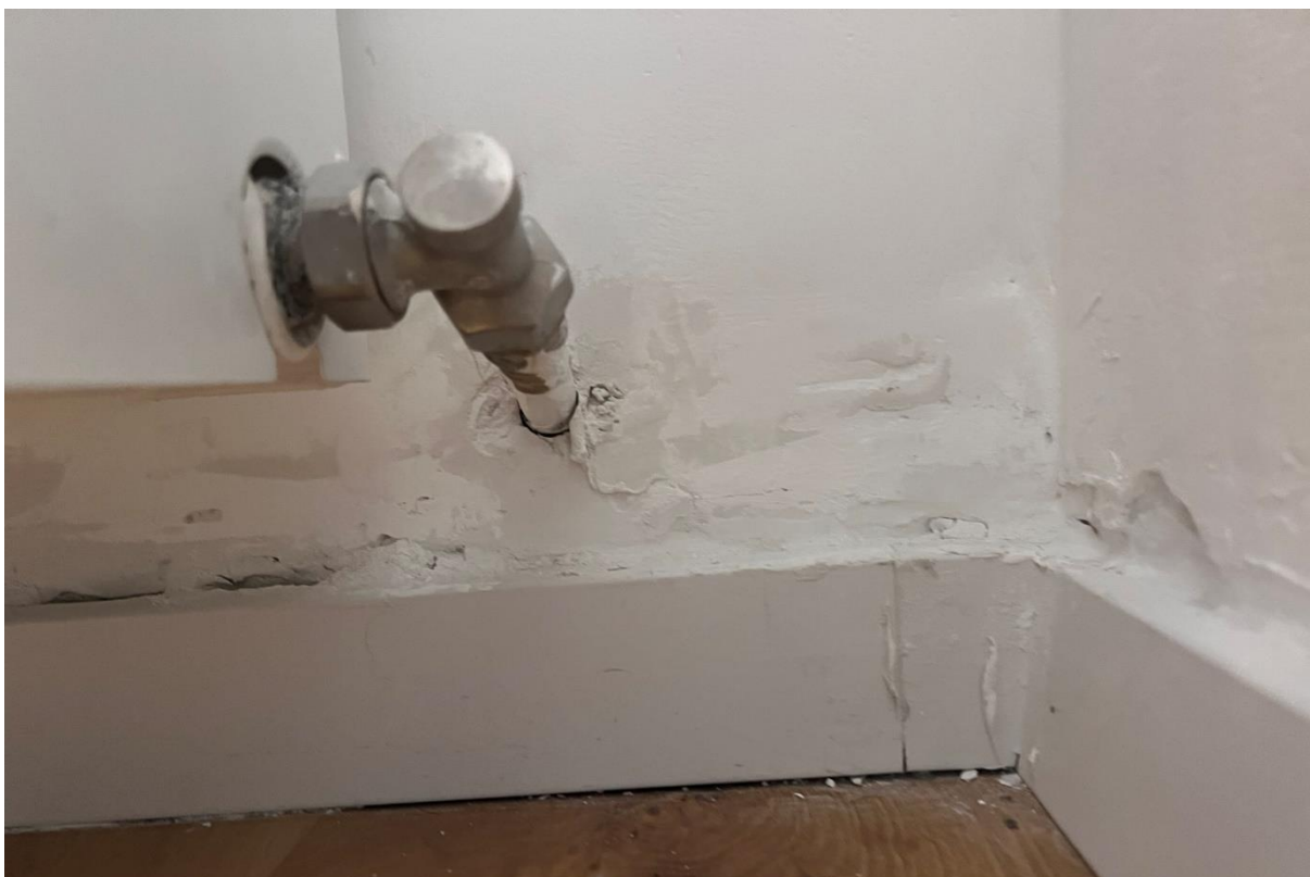
Fot.15. Instalacja centralnego ogrzewania – montaż grzejnika
