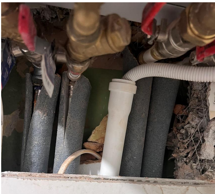
Fot.3. Podłączenie odprowadzenia skroplin do kanalizacji
