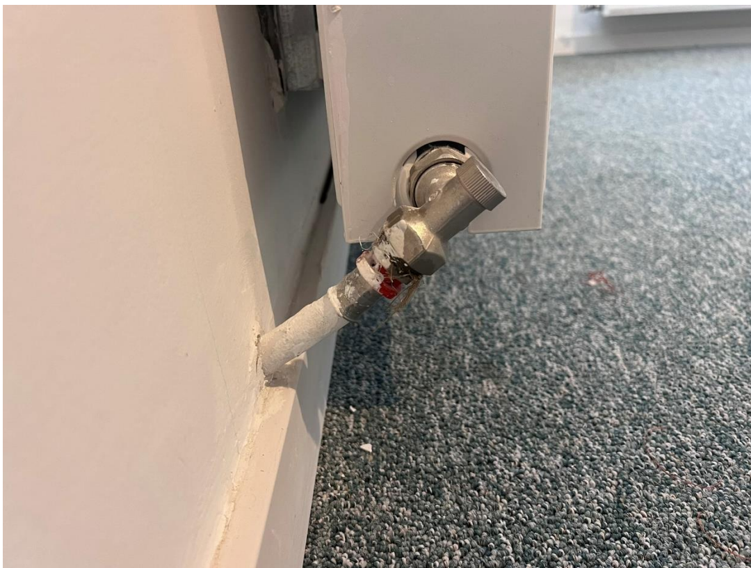
Fot. 19. Instalacja centralnego ogrzewania – montaż grzejnika
