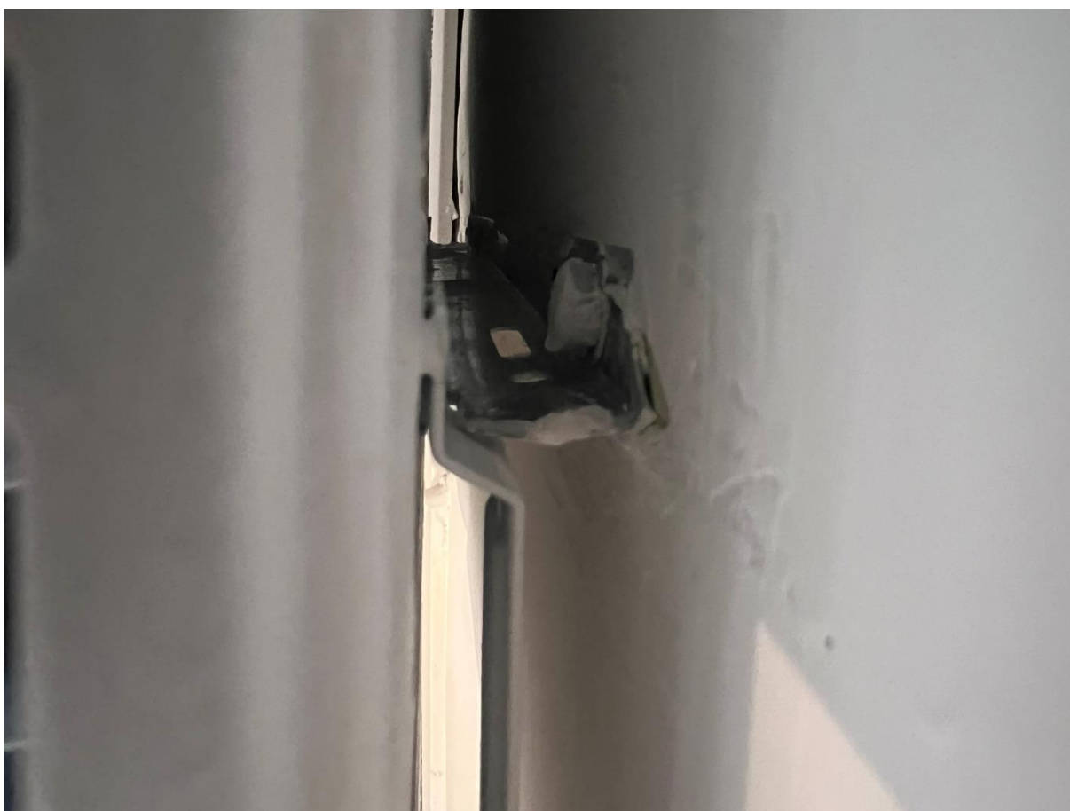
Fot.25. Instalacja centralnego ogrzewania – montaż grzejnika
