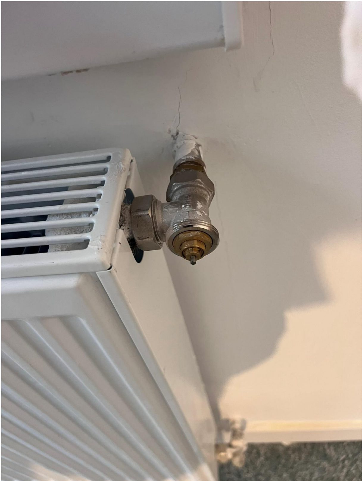
Fot.23. Instalacja centralnego ogrzewania – montaż grzejnika
