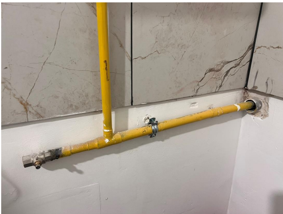
Fot.5. Instalacja gazowa – przygotowanie pod podłączenie kuchenki
