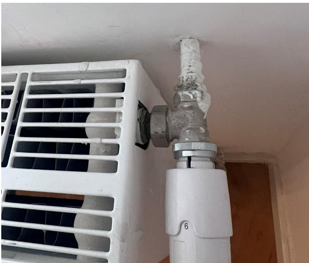
Fot.16. Instalacja centralnego ogrzewania – montaż grzejnika
