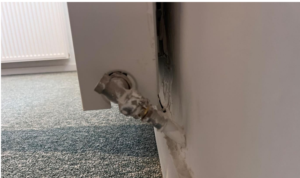
Fot.24. Instalacja centralnego ogrzewania – montaż grzejnika
