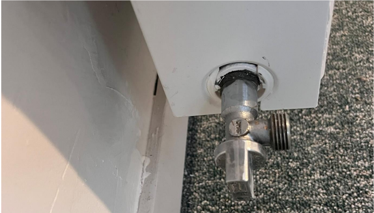
Fot.21. Instalacja centralnego ogrzewania – montaż grzejnika
