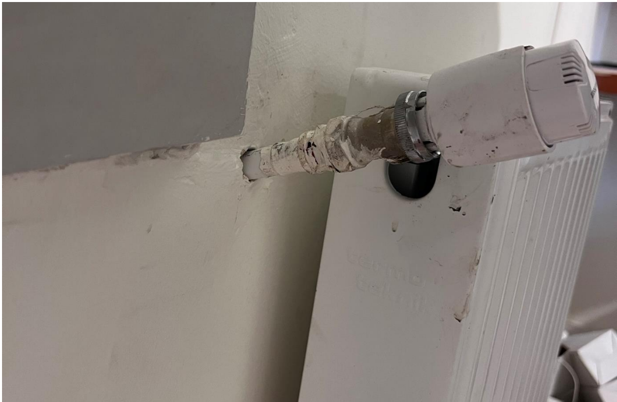
Fot.9. Instalacja centralnego ogrzewania – montaż grzejnika
