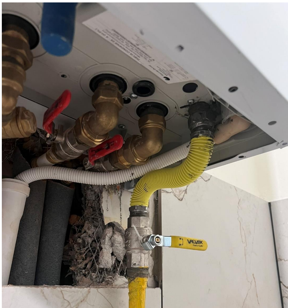
Fot.2. Podłączenie podejść pod kocioł gazowy
