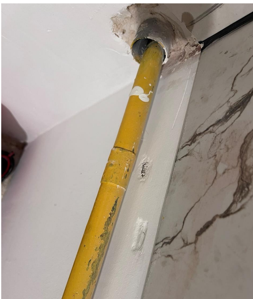
Fot.12. Instalacja gazowa – sposób wykonania
