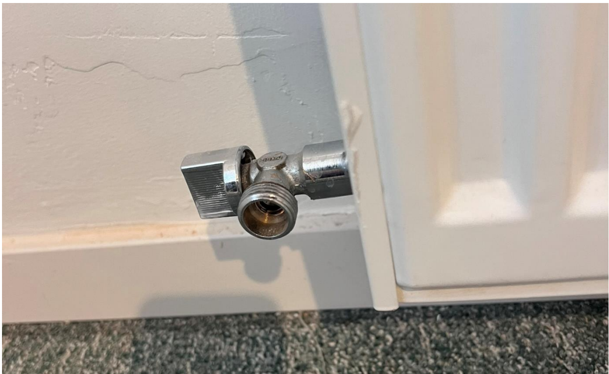
Fot.22. Instalacja centralnego ogrzewania – montaż grzejnika
