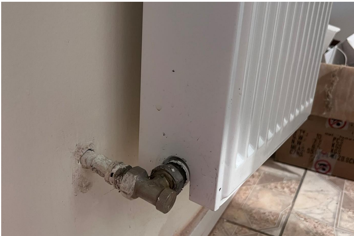
Fot.10. Instalacja centralnego ogrzewania – montaż grzejnika
