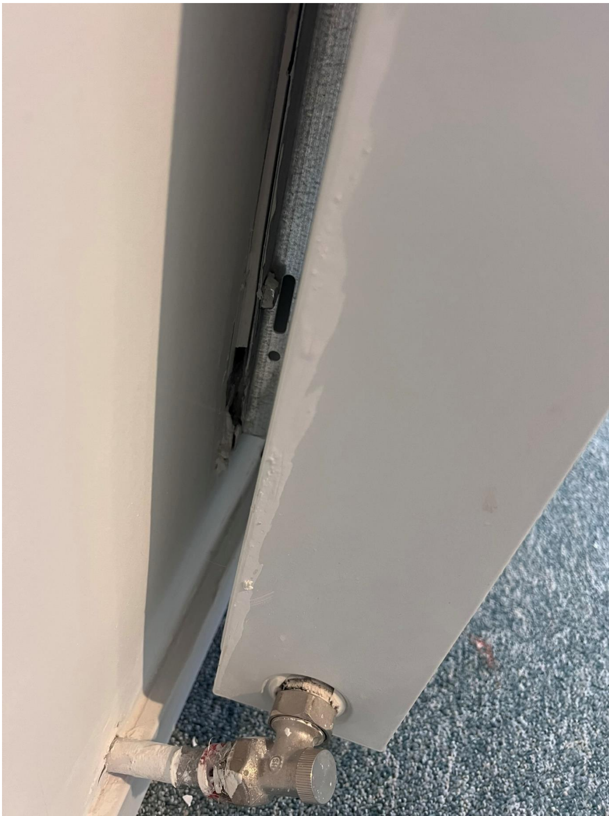
Fot.20. Instalacja centralnego ogrzewania – montaż grzejnika
