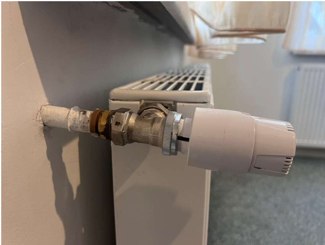
Fot. 18. Instalacja centralnego ogrzewania – montaż grzejnika
