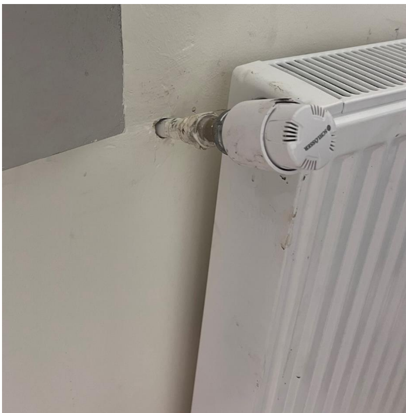
Fot.8. Instalacja centralnego ogrzewania – montaż grzejnika
