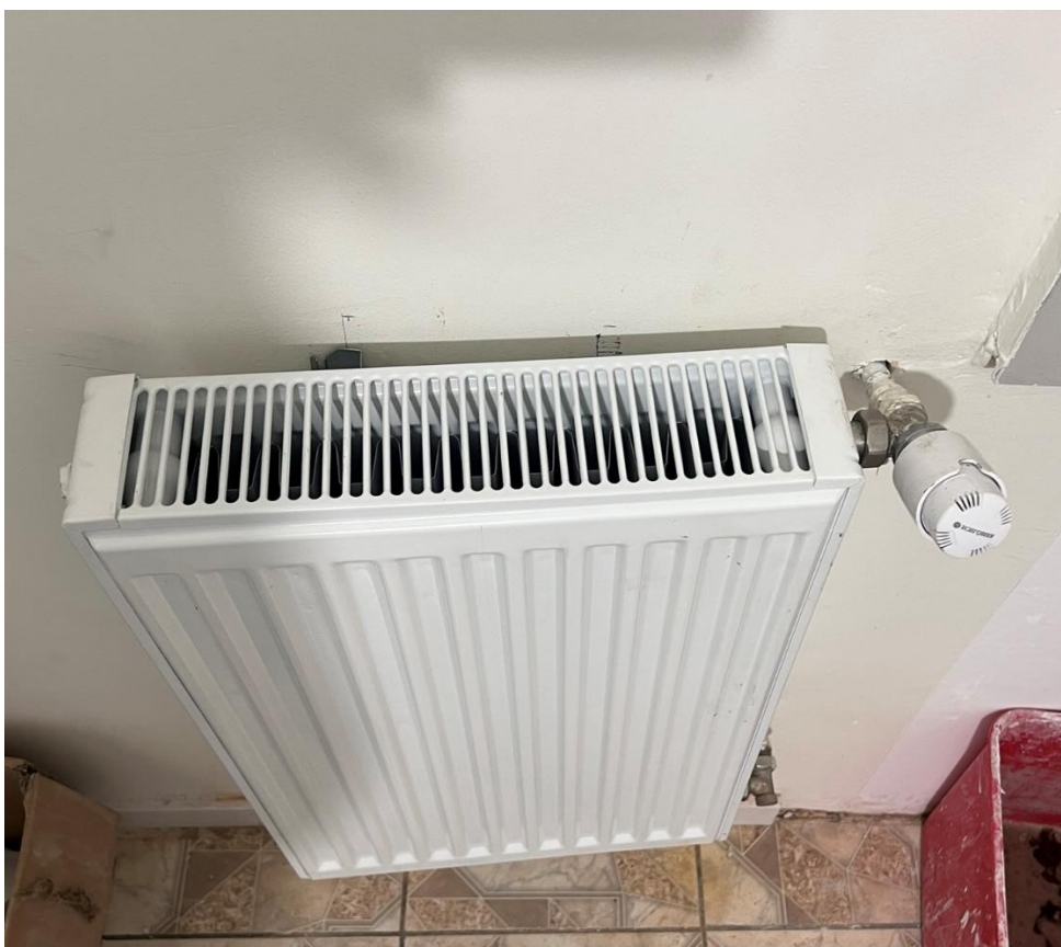
Fot.6. Instalacja centralnego ogrzewania – montaż grzejnika
