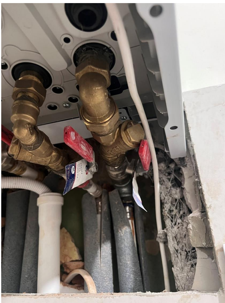
Fot.4. Podłączenie podejść pod kocioł gazowy
