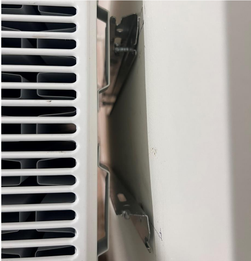
Fot.7. Instalacja centralnego ogrzewania – montaż grzejnika
