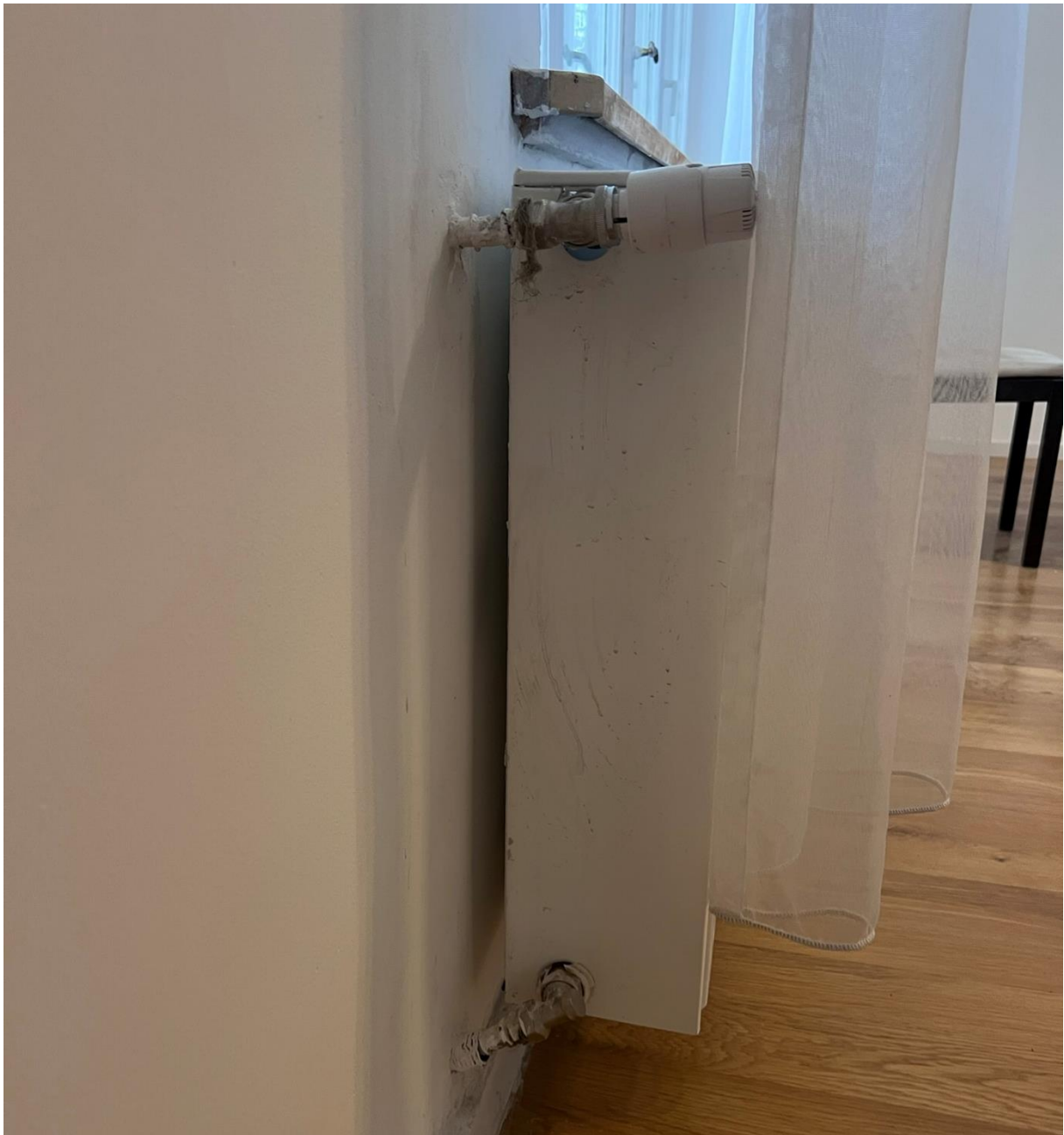
Fot.17. Instalacja centralnego ogrzewania – montaż grzejnika
